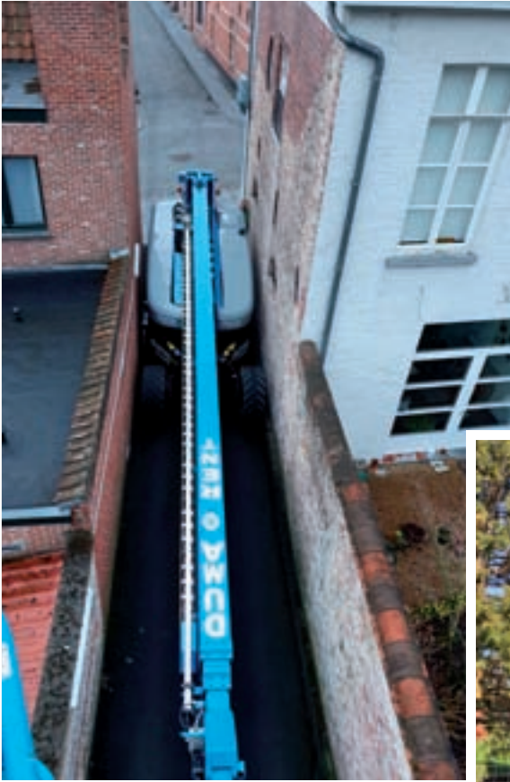
GENIE SX135XC @Brugge Schilderwerken aan schouw
