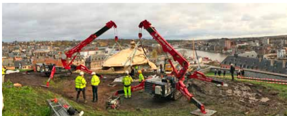
2x UNIC 706 / hefvermogen 6 ton op 3 m / maximum hijshoogte 18.5 m
